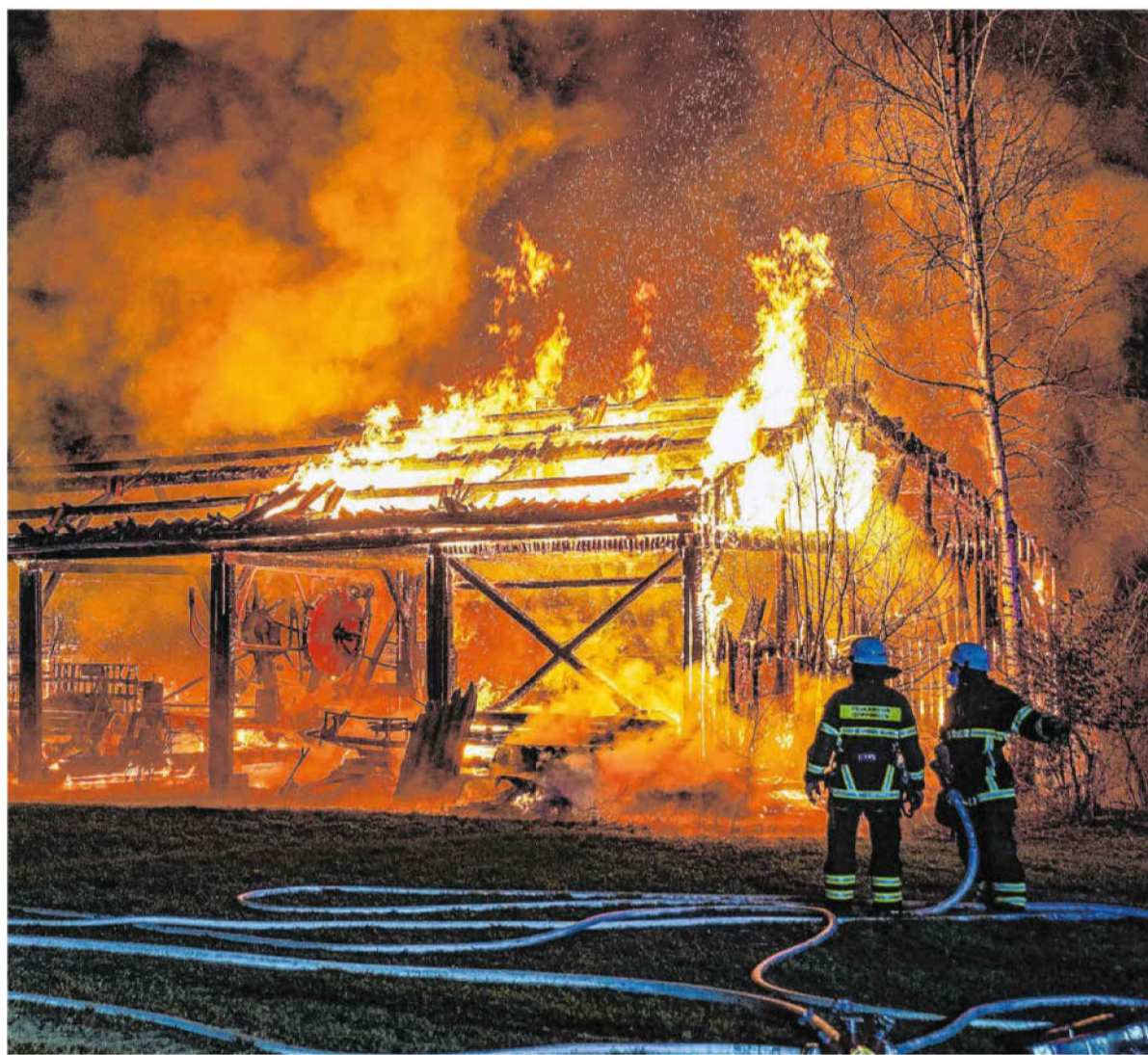
Die Feuerwehren aus Jebenhausen und Göppingen löschten am Mittwochabend einen Scheunenbrand in Jebenhausen und schützten ein nahe stehendes Wohnhaus vor den Flammen. Foto: SDMG
