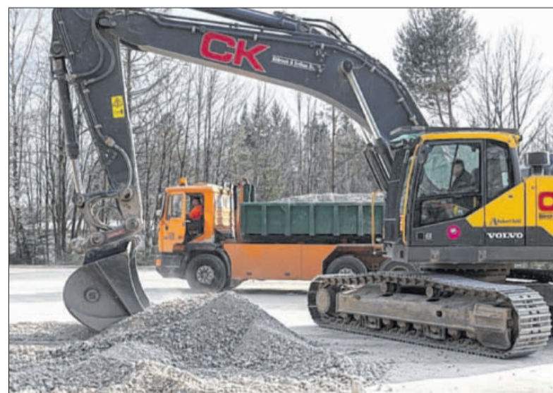
Von einigen der abgerissenen Gebäuden im Bundeswehrdepot bei Wangen ist nur noch Schutt übrig. Der Abbruch sorgte jedoch für Aufregung. Foto: Staufenpress
